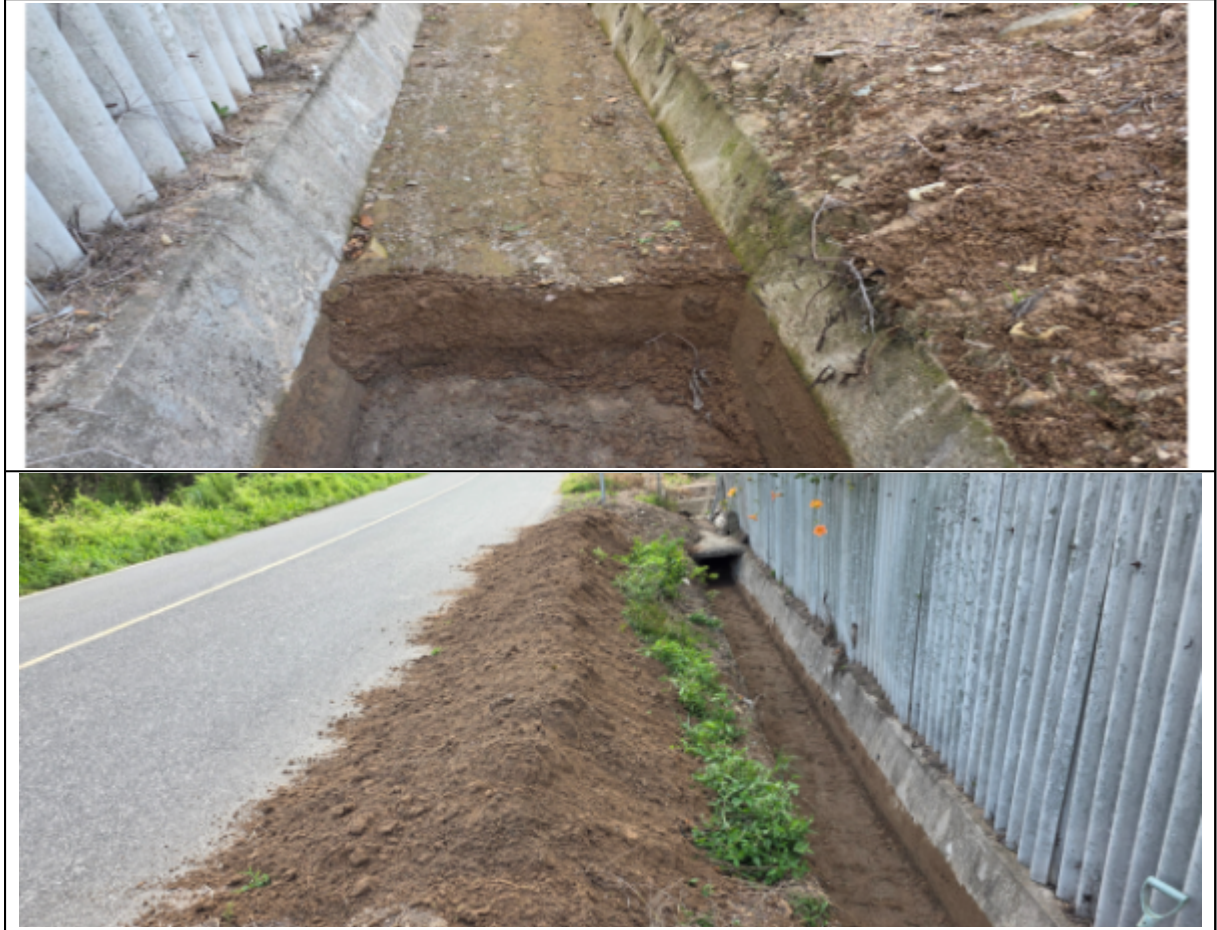
【그림 3】 2025년 배수로 토사 퇴적 및 제거 사진
