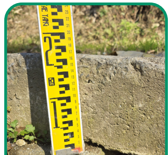
민원도로 콘크리트 두께
