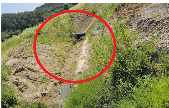
(콘크리트 원형 배수관로)
