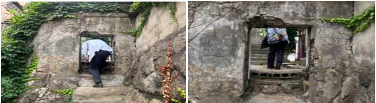
개구멍 통로 현장 사진
